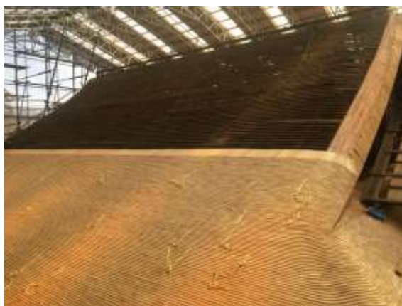
手前が葺き替え後の新しい屋根板です。
